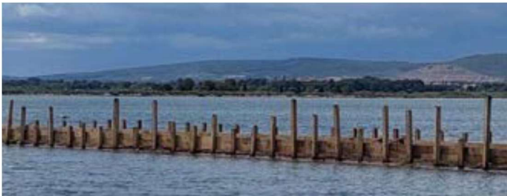
Travaux le 15 mai
