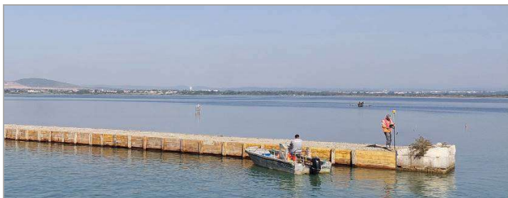
Travaux le 31 juillet
