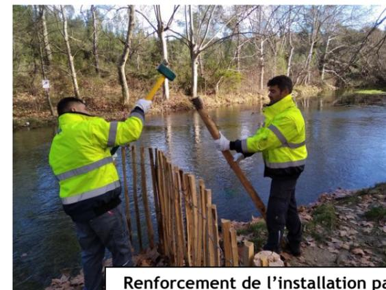
Renforcement de l'installation par la mise en place de jambage en châtaignier
