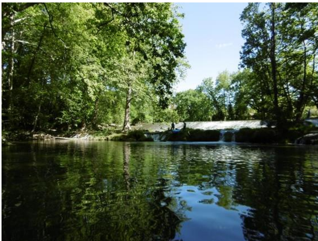
Passage du seuil marquant la fin du tronçon 22 (photo prise le 25/05/21)
