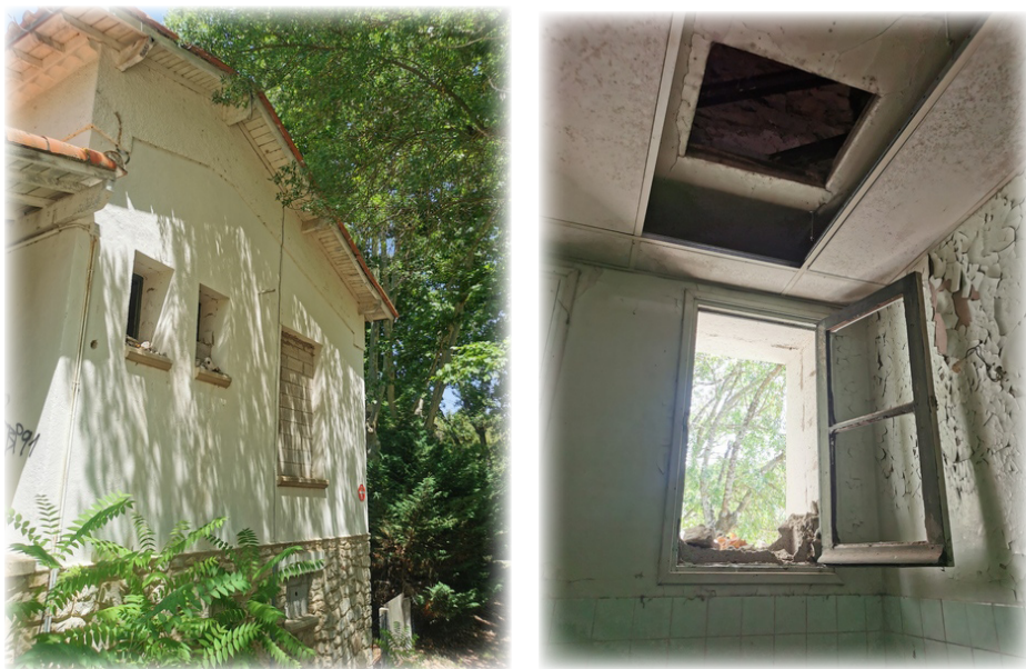
Figure 28 : Façade sud de l'ancienne maison du gardien (à gauche), et trappe d'accès aux combles dans la maison (à droite)
