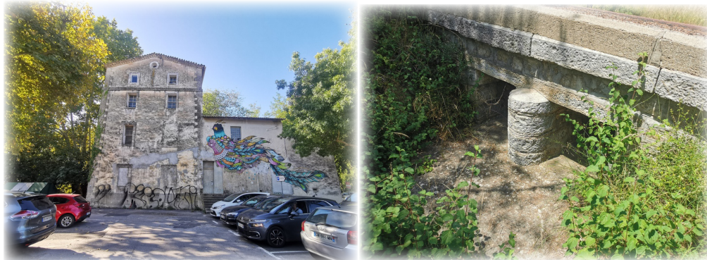
Figure 34 : Moulin de la Clinique du Parc (à gauche), Ouvrage hydraulique 1 de la RD112 (à droite)
